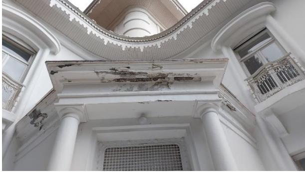
Resim 8. Atatürk Köşkü giriş kapı sundurma deformasyonları.
