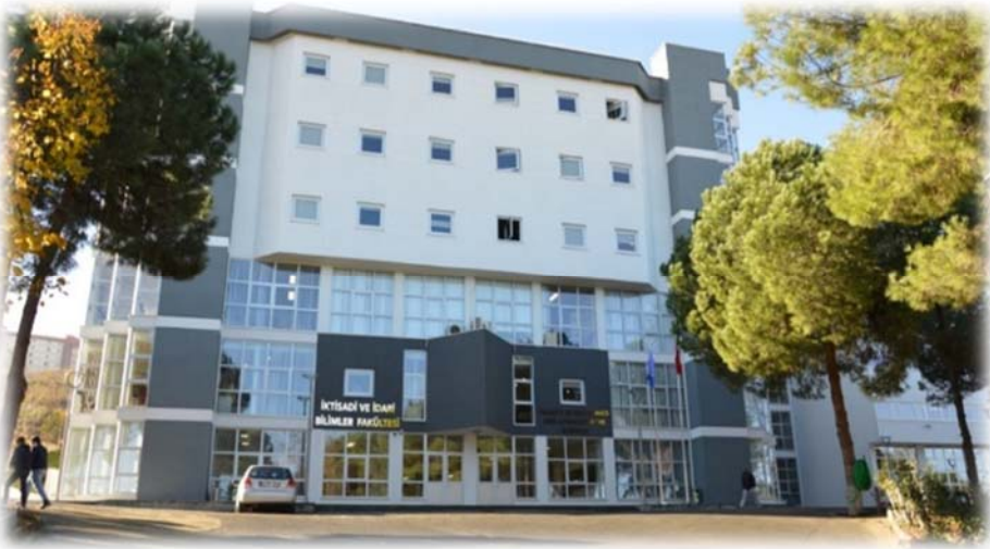
Fakülte Binası İdari Blok
