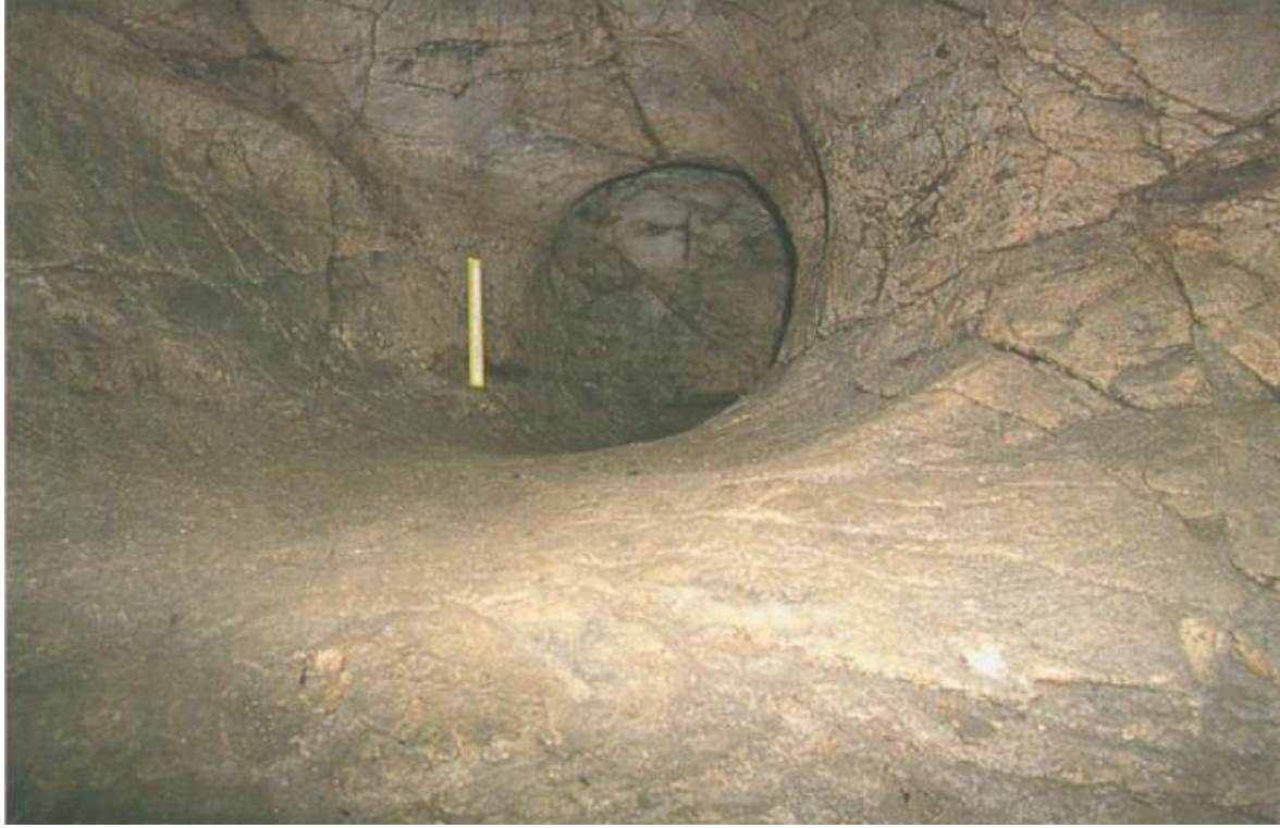
Şekil 5. Kestel madeninde ateş kurma ile sürülen bir açıklık (Craddock, 1992).
