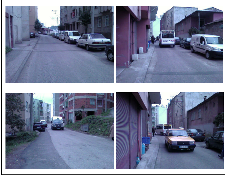
Şekil 56. Sütlaç Kavşağı ile Gedikkaya Mahallesi arasındaki güzergahın belli noktalardan görünüşü
