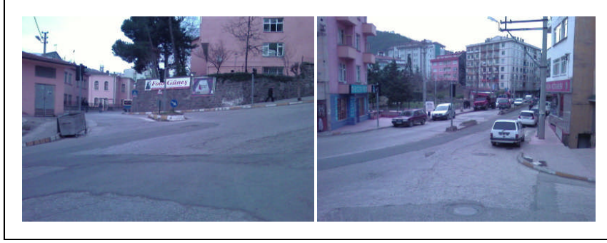
Şekil 31. 1 Nolu Sağlık Ocağı Kavşağı görünümü
