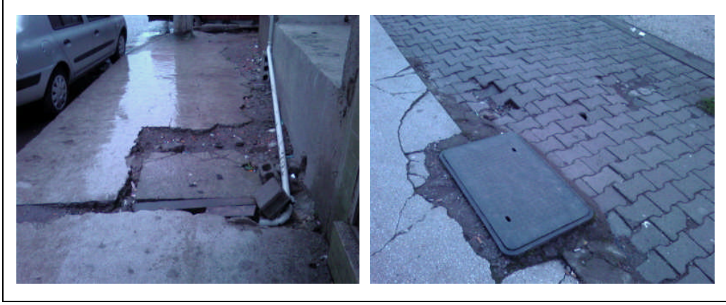
Şekil 58. Hat üzerindeki kaldırım döşemeleri
